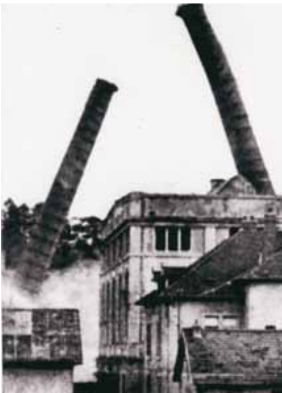
Am 30ten August 1966 brachen die zwei letzten Ziegelsteinschote der Hochöfen 1 und 3 durch Sprengung in sich zusammen. Sie hatten eine Höhe von 65m und waren die letzten Wahrzeichen einer einstig vielversprechenden Industrie. Nach und nach fielen auch die anderen Gebäude dem damaligen Abbrucheifer zum Opfer. Erhalten blieben 3 verwahrloste Bauten. © Tageblatt-Archiv.
